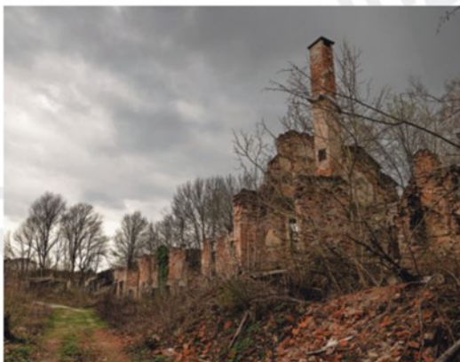
Tako je danes videti zapuščeno zemljišče, kjer so od tovarne Tovil ostale le še ruševine.
